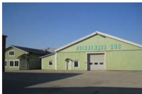
Hemgårdens husfabrik, Östersund (totalrenoverad 1992)
